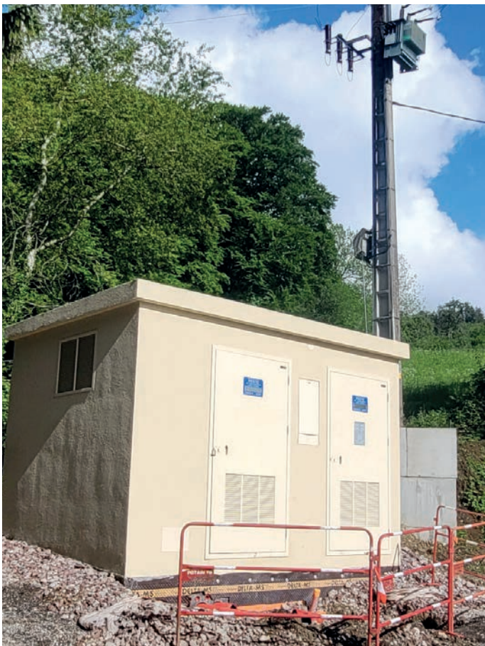
Transformateur de Floret Poste d'étoilement entre Viuz et Boège. L'ancien transformateur sur le poteau sera déposé en même temps que la mise en route du réseau.
