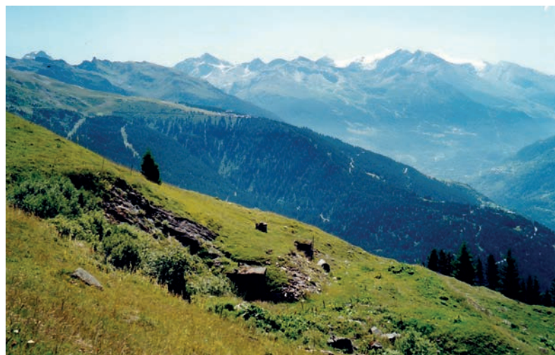
La casemate du Combotier aujourd'hui avec les 2 entrées (gros blocs de béton) et la cheminée d'aération (petit bloc de béton au-dessus). Au loin la route du petit St Bernard.
