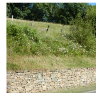
Mur de soutènement et talus
