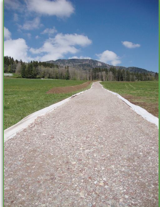
Tous les pylônes vont être vérifiés, renforcés au niveau des encrages béton et un pylône à minima va être remplacé au dessus de Curseilles. Ceci permettra de sécuriser notre alimentation électrique pour l'avenir. Des pistes ont donc été créées afin de faciliter l'accès aux chantiers. La création des pistes est le meilleur compromis prix/délai.
