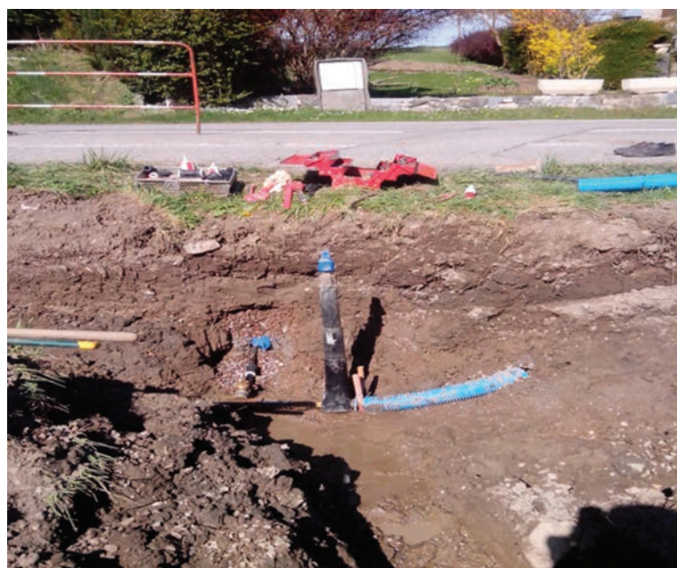
Intervention suite à une fuite d'une vanne d'alimentation à Curseilles le 9 avril 2014.
